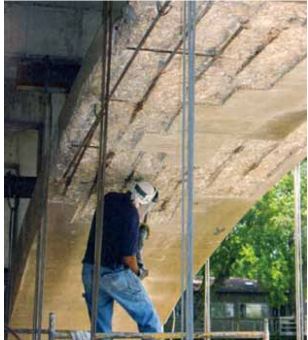
La reparación de estructuras es frecuente
