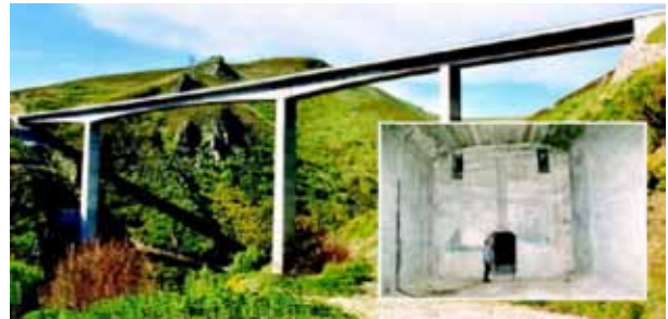
Ahora las obras importantes como los puentes, llevan cámaras de registro en donde se monitorea permanentemente el comportamiento de la estructura.
