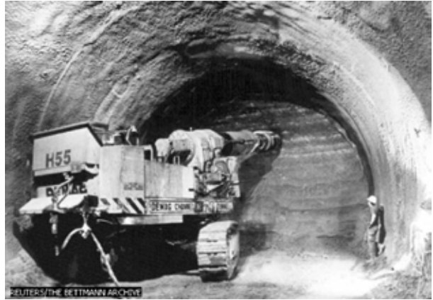
Perforación de un túnel
