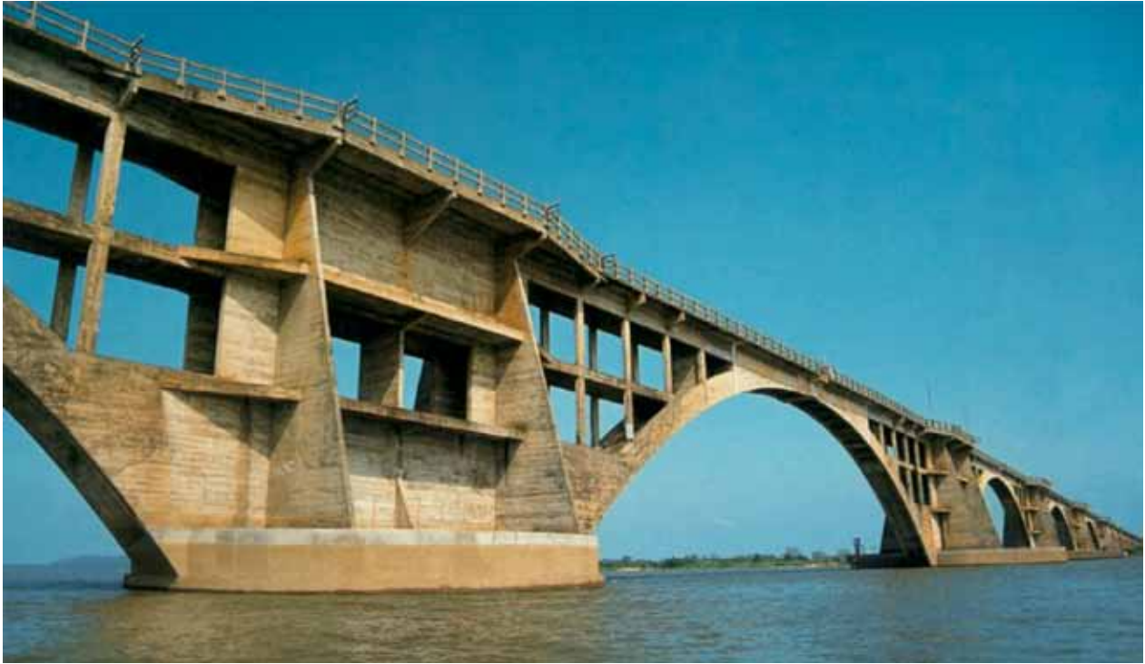
Puente ferroviario sobre el río Paraguay, 1.947
