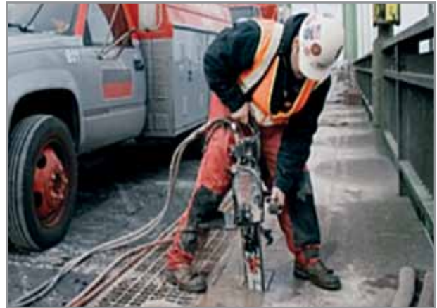
Obtención de Vigas Aserradas
