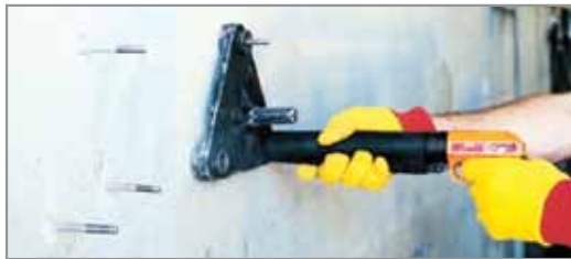
Penetración (Sonda de Windsor) ASTM C 803
