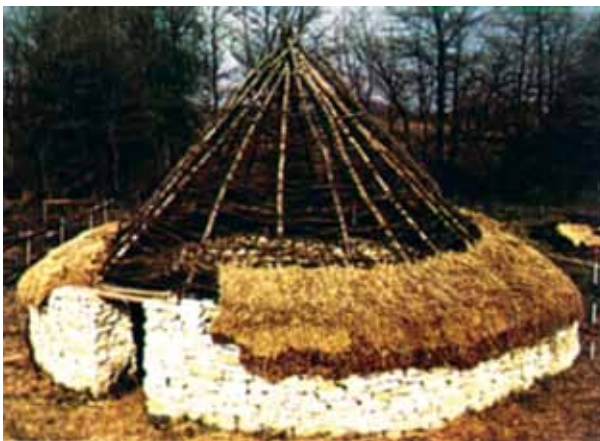
La arcilla también puede unir pedazos de piedras. Esta recreación de una construcción de hace miles de años, muestra paredes levantadas con pedazos de roca unidas con barro, sobre las que se asienta un esqueleto de varas de madera que luego se reviste con paja hojas y ramas.
