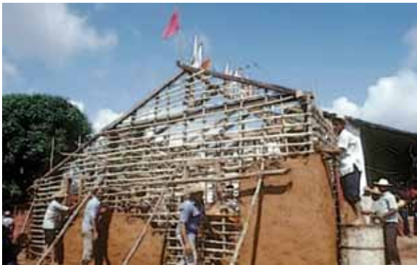
Construcción de bahareque en Centroamérica.: paredes de arcilla armadas con tiras de madera. Así se construye en muchas zonas rurales de América.
