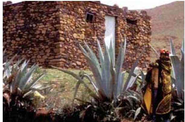
Mampostería de piedra y arcilla en África, La cubierta sigue siendo de paja.
